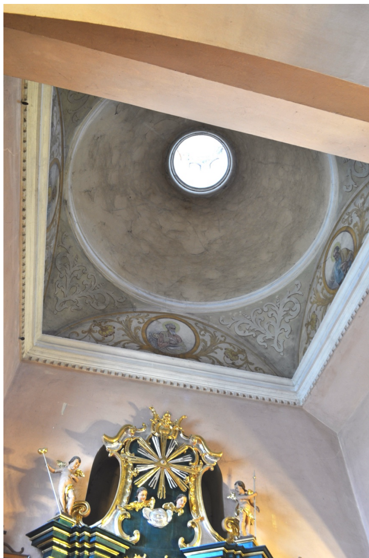
Fot. 5. Kupała dawnej kaplicy św. Benedykta w nawie północnej w kościele parafialnym pw. Wniebowzięcia NMP w Konieńtotech. Stan przed konserwacją.
